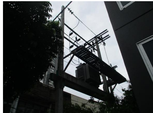
รูปที่ 19 หม้อแปลงไฟฟ้า
