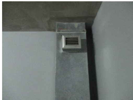
รูปที่ 27 ระบบดูดอากาศในห้องพักขยะแห้ง
